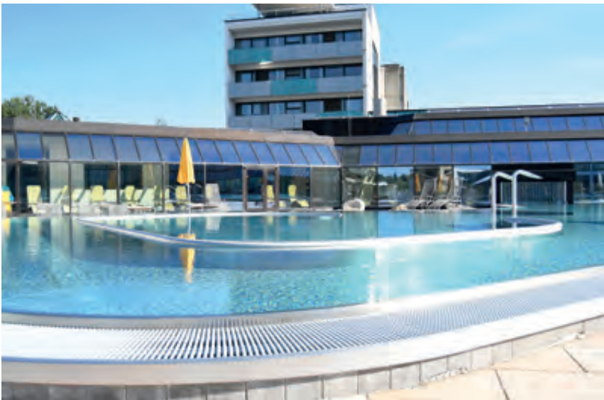
Thermalaußenbecken mit Strömungskanal
