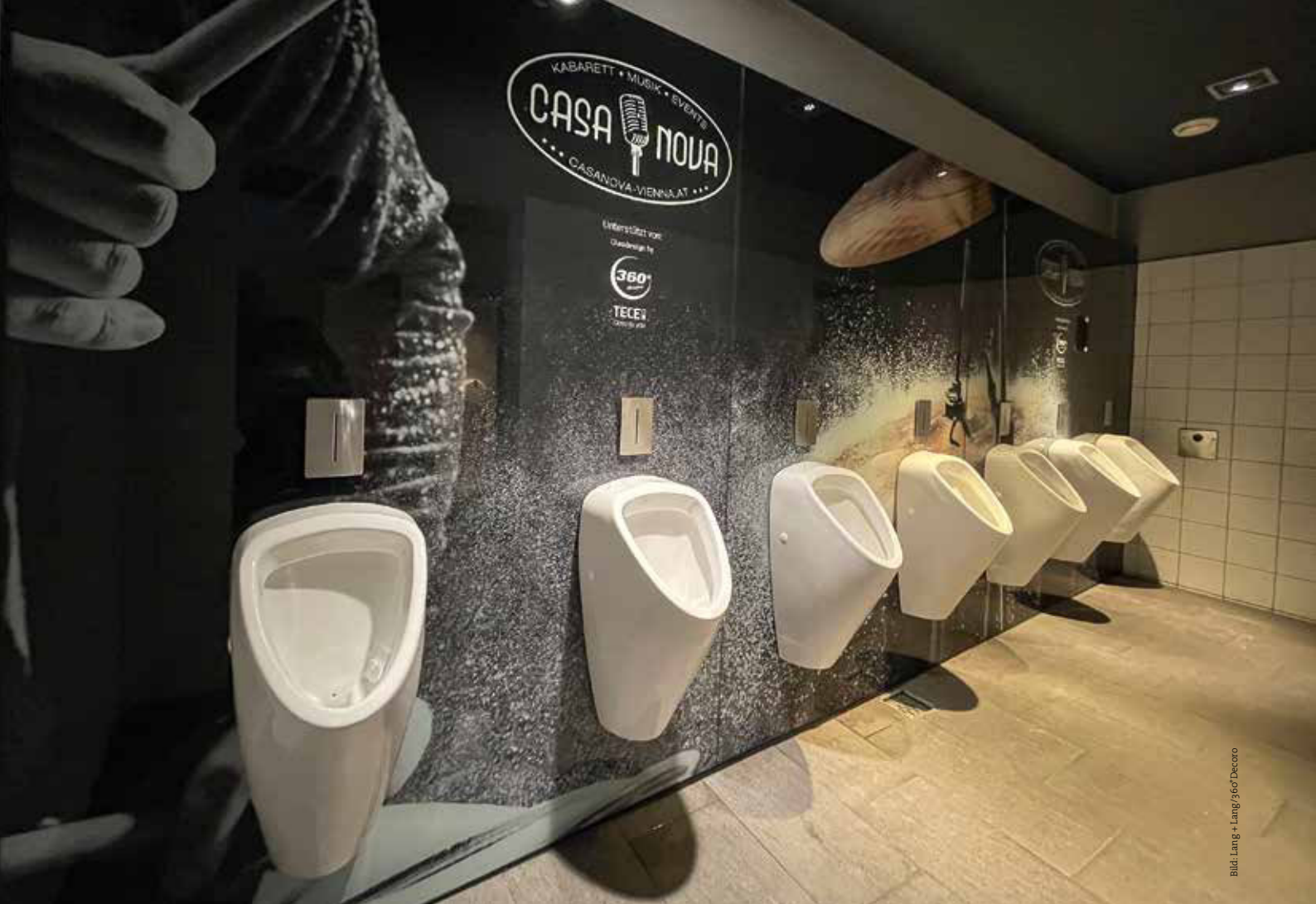
Vorgefertigte Elemente verkürzen Montagezeiten und reduzieren Lärm und Schmutz. Im Bild: ein halböffentliches Bad im Kabarett Casanova, Wien, mit individualisiertem Design, gefertigt aus SanMod-Modulen der Lang + Lang GesmbH.
