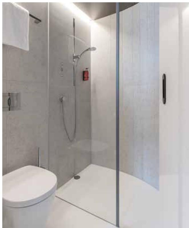
Die Armaturen in den Bädern des B'mine wurden bündig in die Wand gesetzt. Auch die Rainshower schließt mit der Decke ab. Das spart Platz und alles lässt sich leichter reinigen.
